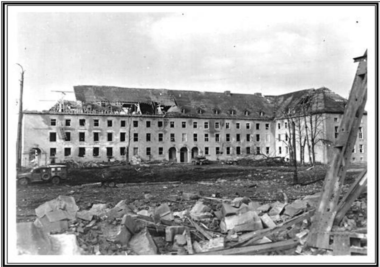
Das **Amtsgericht in Düren** wurde bei dem Luftangriff am 16.11.1944 **nicht direkt** von Bomben getroffen. Die Schäden an Dach und Fassade rührten vornehmlich von Artilleriebeschuss und Druckwellen her.
