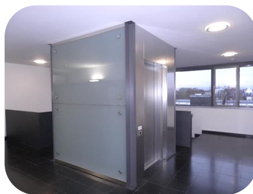
Personenaufzug bis zur 3. Etage
