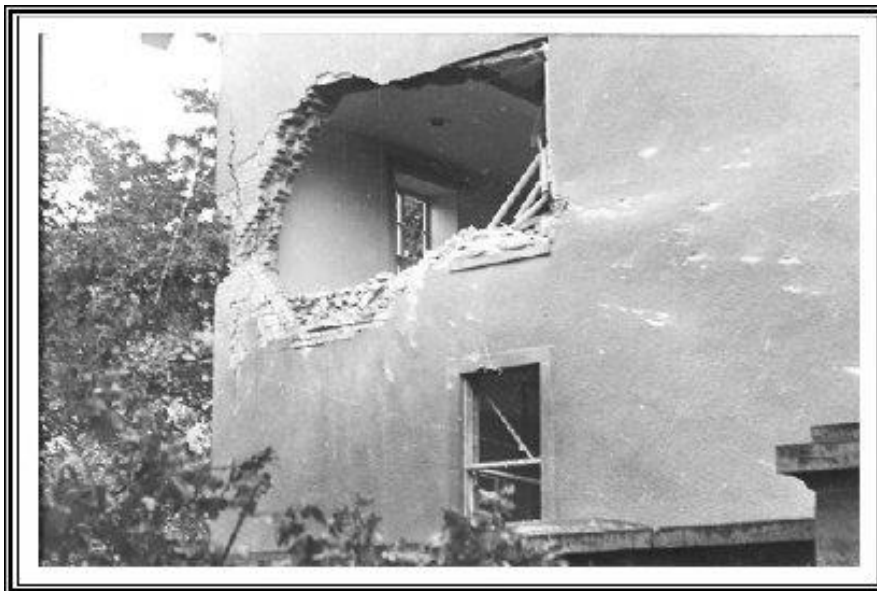
Schäden am Gebäude (Eingang Parkplatz) im Okt. 1944 durch Artilleriebeschuss. 27
