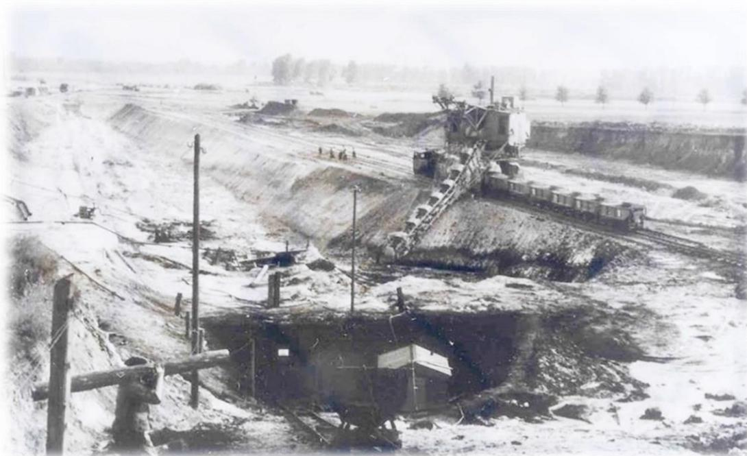
Da man in der „**Grube Victor**“ in Füsseich-Geich erst bei 60 m Tiefe auf Braunkohle stieß, bewältigte man den Abbau in zwei Trassen. Neben einem **417 Tonner** setzte man einen kleinen Schaufelradbagger ein sowie einen **Eimerkettenbagger** (Foto oben) mit umlaufender Eimerkette über mehrere angebrachten Schaufeln.
