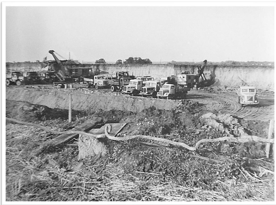
Kurz nach der Aufnahme der Grubenarbeiten musste der Abtransport des Abraums noch mit **Lastwagen** und später dann mit **Lokomotiven** bewältigt werden. Für den Abtransport wurden u.a. 4 Lokomotiven der **Firma Schöttle & Schuster aus Türrnich** und weitere Loks aus dem Werk der Firma Viktor Rolff KG in eingesetzt
