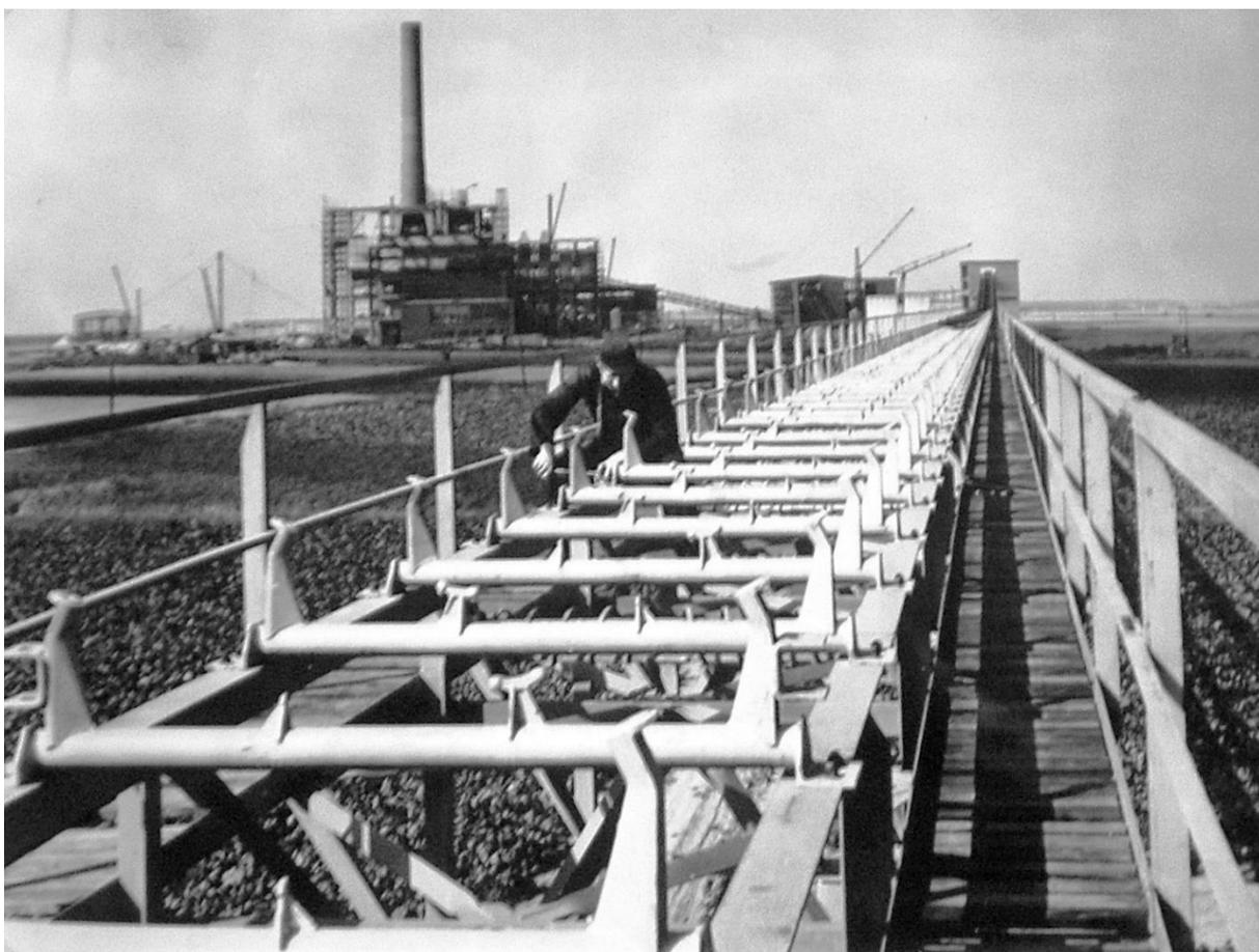
Aufbau eines Teils des Förderbandes nach Fertigstellung der Fabrik nach 1955.
