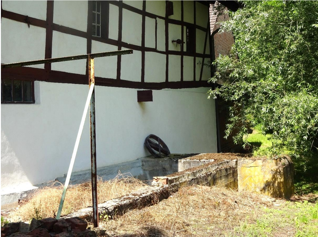
Die Überreste der Mühlenanlage außen. Hier wurde 1937 eine Turbine eingebaut
