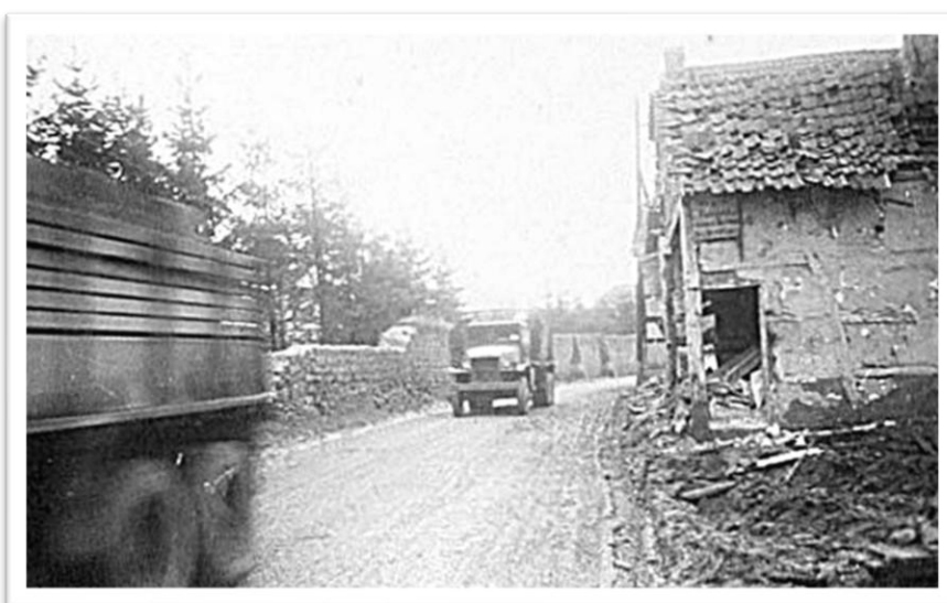
US-Militärfahrzeuge an der Klostermauer in Füssenich am 02.03.1945.
