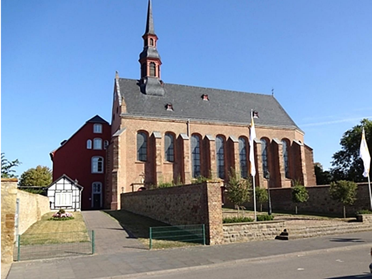
Siebenjochiger Saalbau mit sechseitigem Dachreiter, der wegen Baufälligkeit 2008 erneuert wurde.
